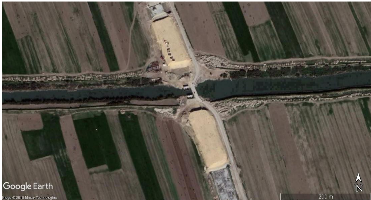
Figure 10 Construction de la traversée du fleuve Mejerda par la nouvelle route de Tunis à Kalaat el Andalus. Photo : Google Earth
